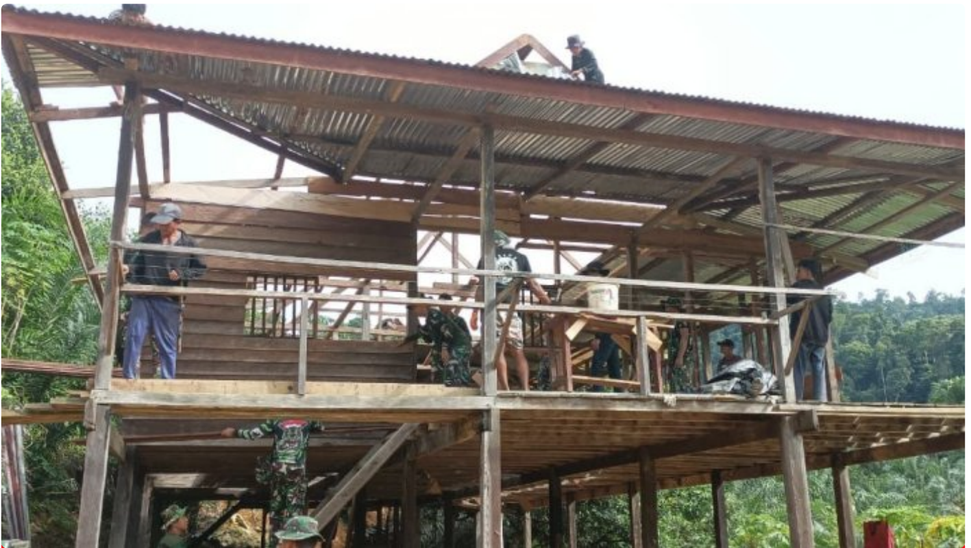
Foto Pembongkaran Rumah Warga
